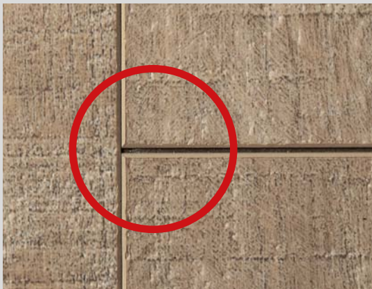
Sol en vinyle conventionnel à noyau thermoplastique et joint ouvert.
