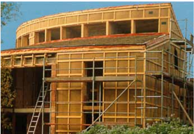
Maison double: toit vert avec 30 cm d'isolation; murs en briques de grand format avec 16 cm d'isolation + panneau de protection de l'isolation Celit 3D
