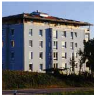
Bâtiments d'entreprise: structure en acier avec 14 cm d'isolation + panneau de protection de l'isolation Celit 3D, finition en tôle.
