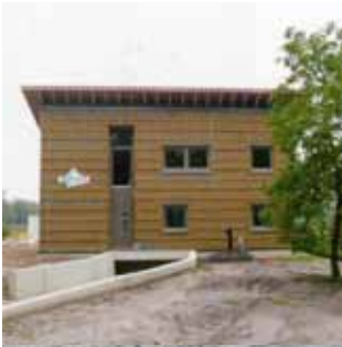
Des 10 premiers bâtiments construits en Belgique selon le standard de la maison passive, 9 ont été réalisés avec des panneaux Celit. (WPMC Bocholt; arch. Equilibrium)
