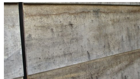
Les surfaces rugueuses sciées sont plus propices à l'accumulation
