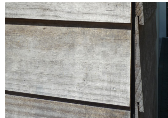
Les surfaces rugueuses sciées sont plus propices à l'accumulation
