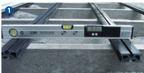
Préparer le sol et fixer le support.
