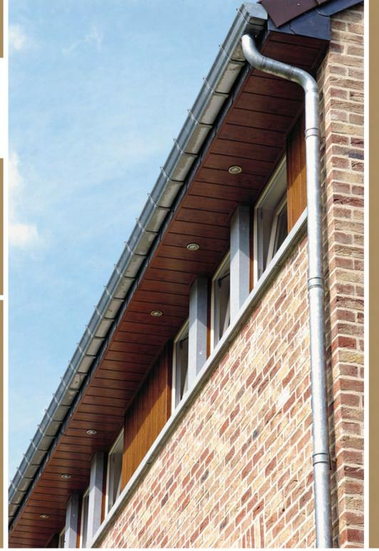
OPERAL est un panneau résistant à l'eau, indéformable, facile à entretenir et imputrescible adapté pour le recouvrement des bandes de rives et des autres éléments de façade.
