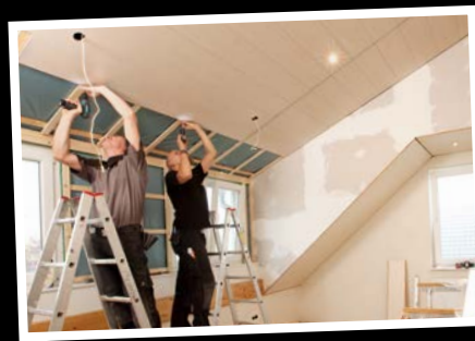
| Le système de lambris amortit les mouvements de la charpente du toit liés à la construction
